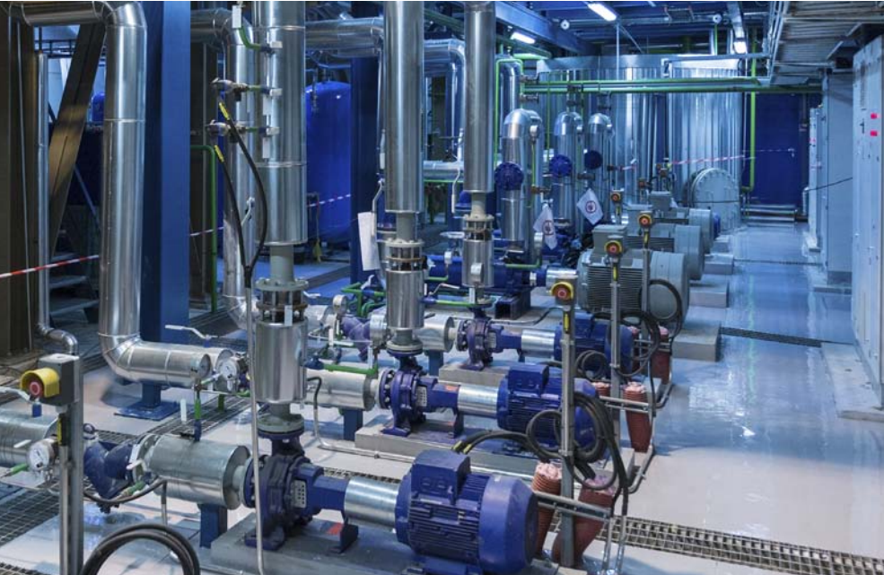
A szivattyúalkalmazások, pl. az épületautomatizálásban, energiatakarékosan működnek a frekvenciaváltókkal
